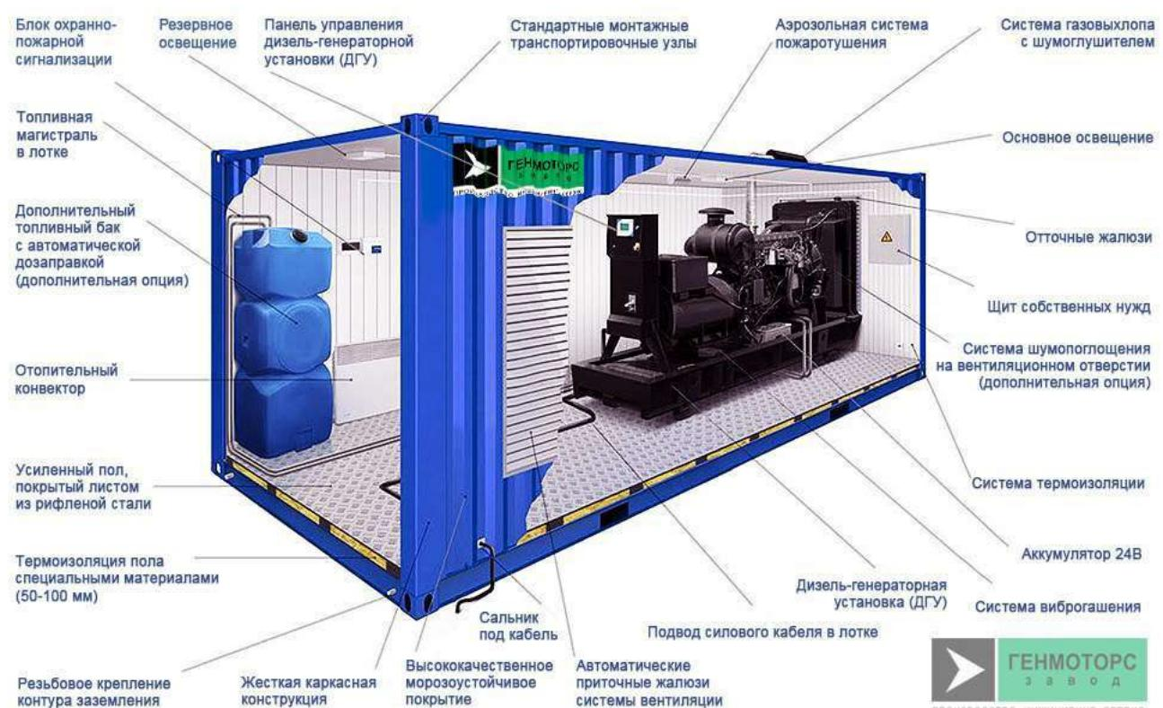
Дизельная генераторная установка FOGO FDF40MS
